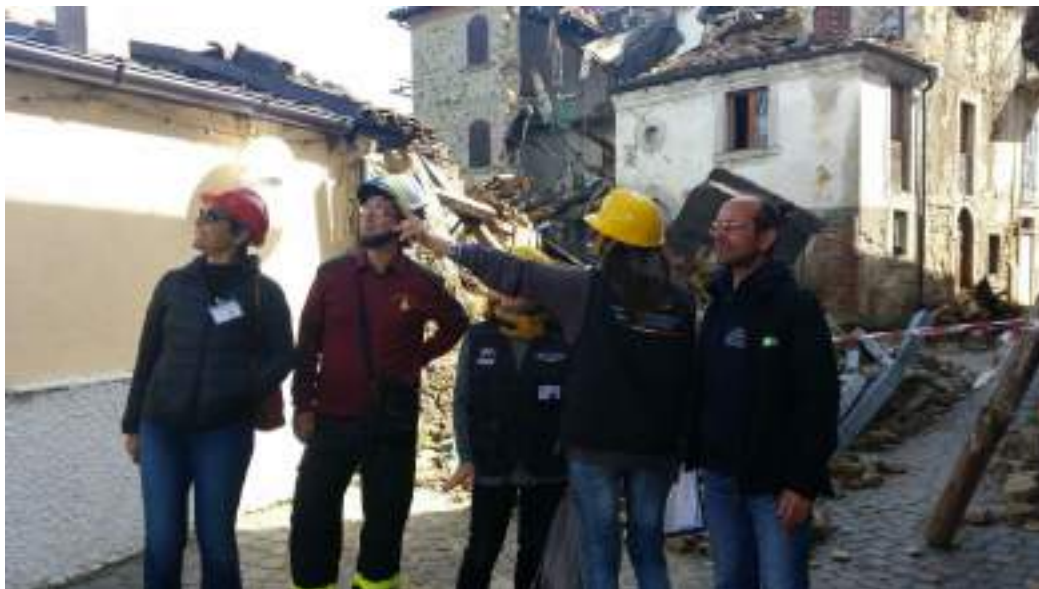
Figura 9 L'attività dei gruppi tecnici di supporto (GTS)
