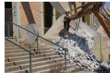
Demolizione plinto
