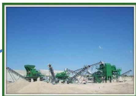
Lavorazione delle macerie nell'impianto di riciclaggio
