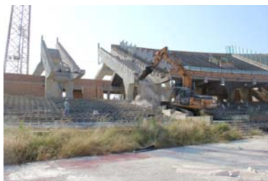
Demolizione trave
