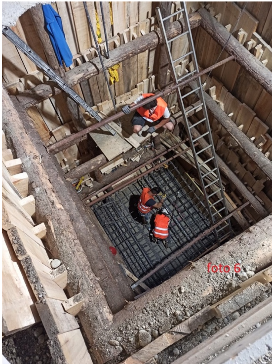
26. Vista di un pozzo con pannelli lignei di contrasto. 27. Vista dell'armatura di un nuovo pilastro.
