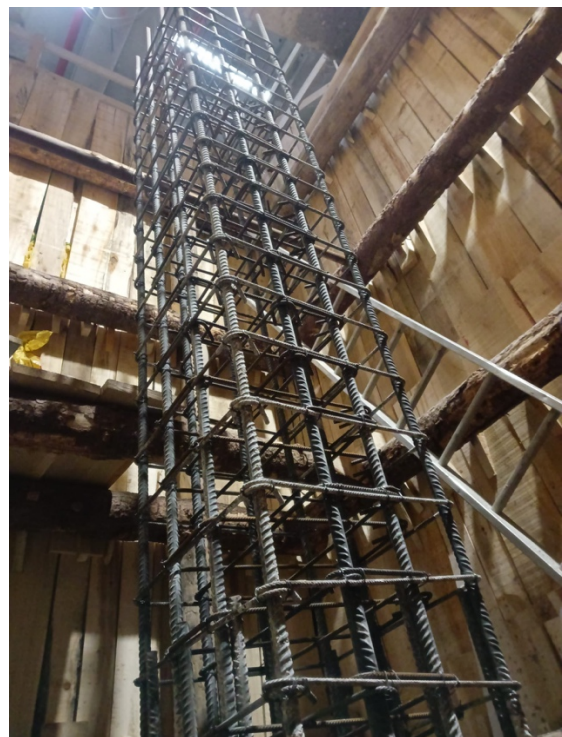
26. Vista di un pozzo con pannelli lignei di contrasto. 27. Vista dell'armatura di un nuovo pilastro.
