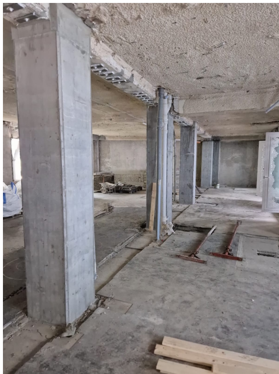
18. Vista dei rinforzi delle travi e ringrosso dei pilastri ai piani fuori terra.
