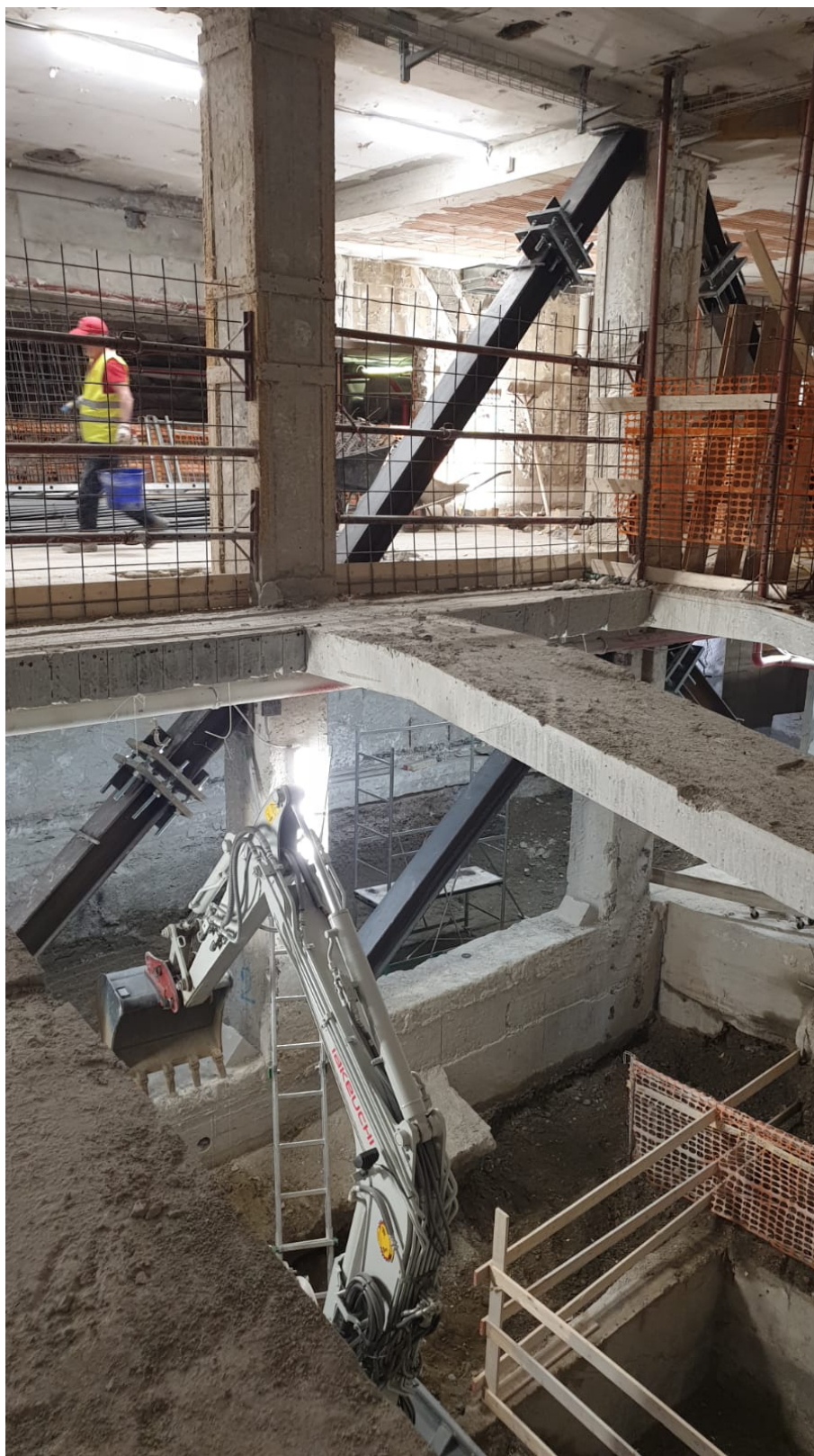
30. Vista del primo e del secondo interrato.
