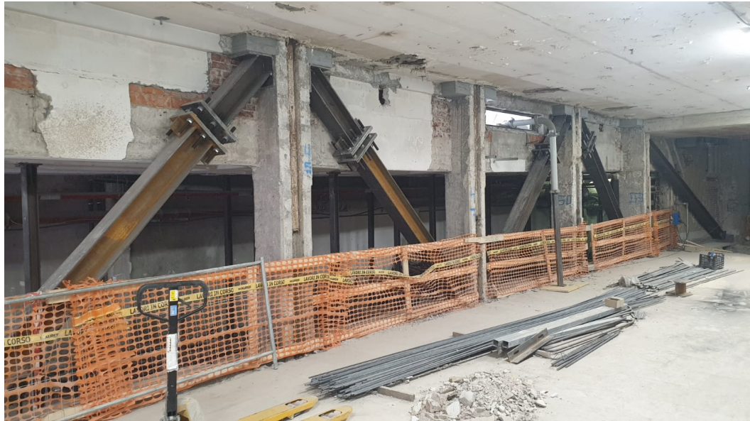
31. Vista dell'interrato con puntellazione.
