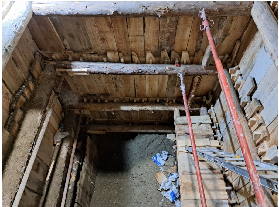
25. Vista di uno scavo di un pozzo.
