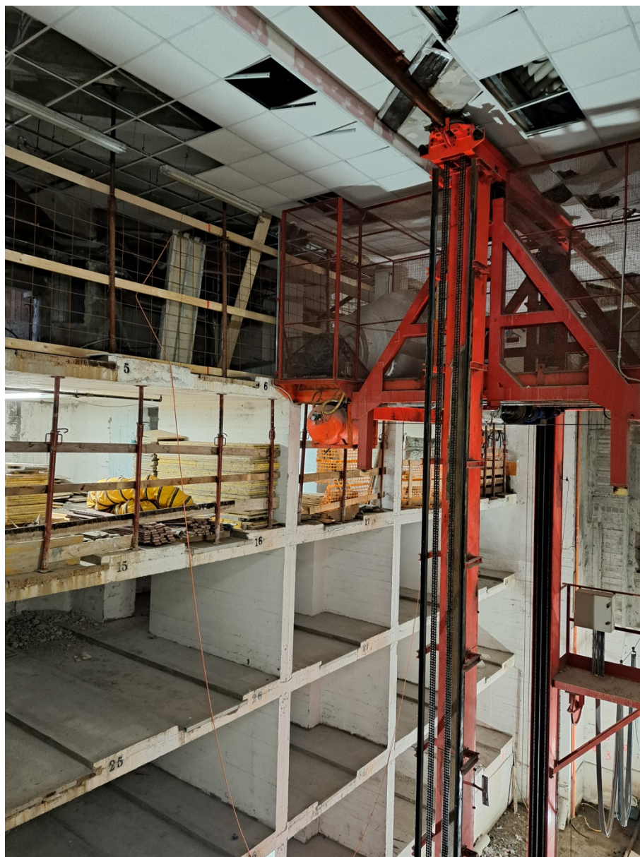
8. Vista interna del parcheggio.
