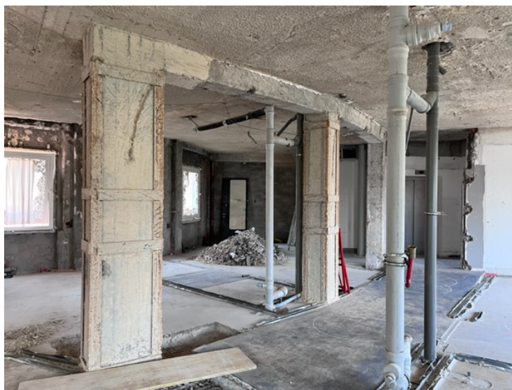
3. Vista di un pilastro di bordo a lavorazioni iniziate.
