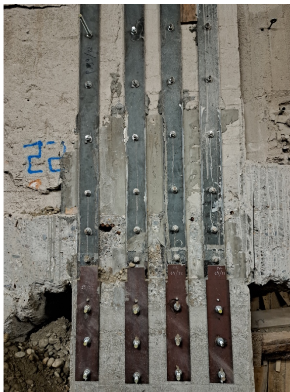
34. Vista di un rinforzo a sottomurazione completata.
