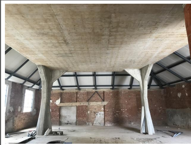
Fase di montaggio copertura magazzino
