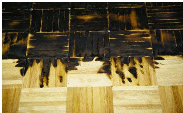
Pavimento In parquet
