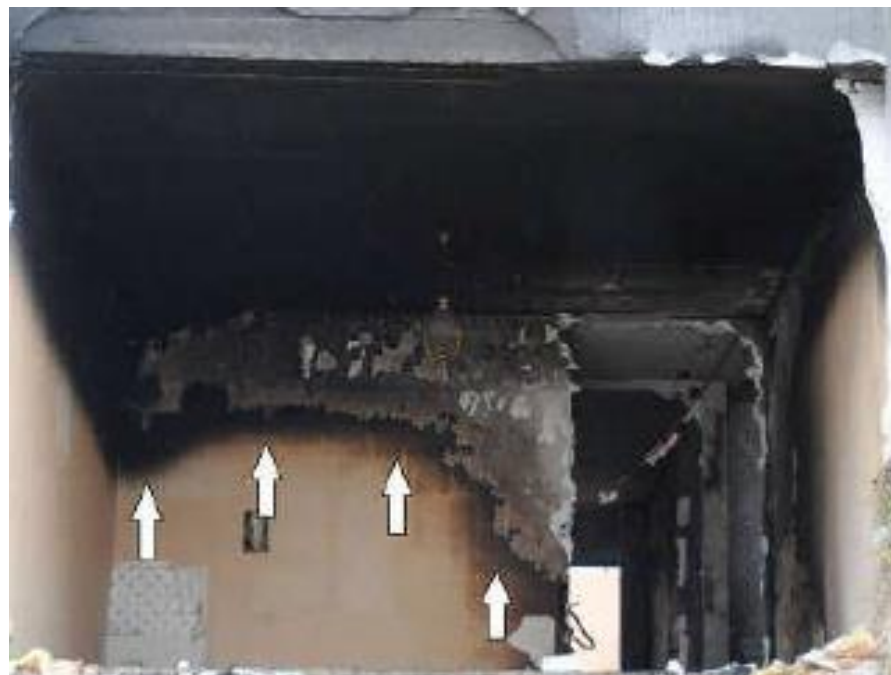
Esempio di linea di demarcazione provocata dal fumo
