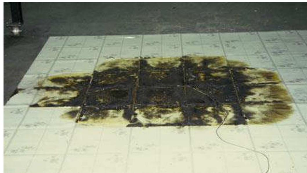
Pavimento In piastrelle in vinile
