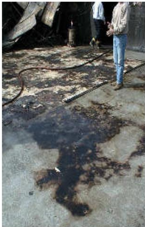
Pavimento In cemento
