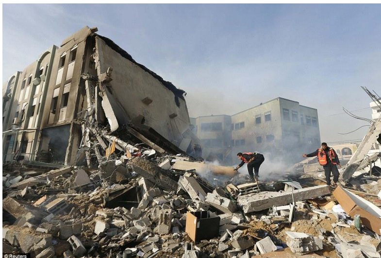
Martellamento contro l'edificio adiacente.
