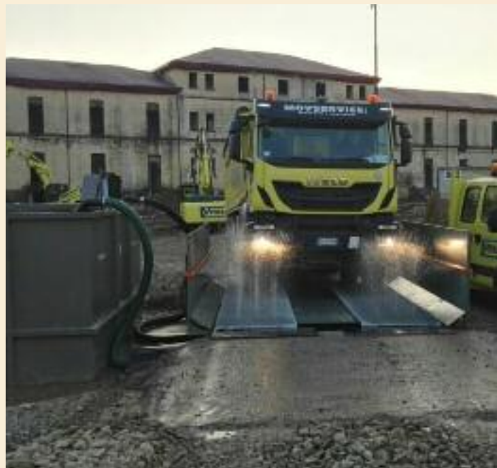
Fig. 4. Lava-ruote e pesa posizionare nei pressi del testo Bonifica.
