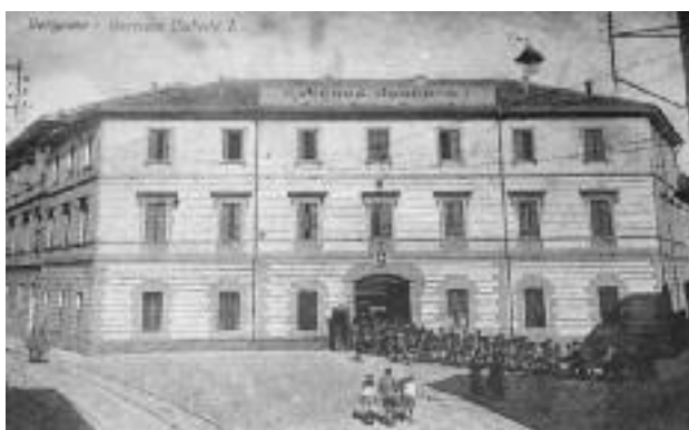
Fig. 33. Facciata principale della caserma.
