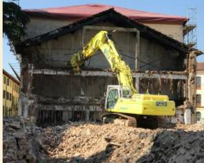
Fig. 3. Demolizione con pinza idraulica.
