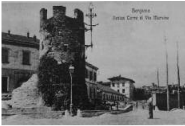
Fig. 28. Il complesso prima della demolizione di San Raffaele e del soprizzo della Colleoni (1901 circa).
