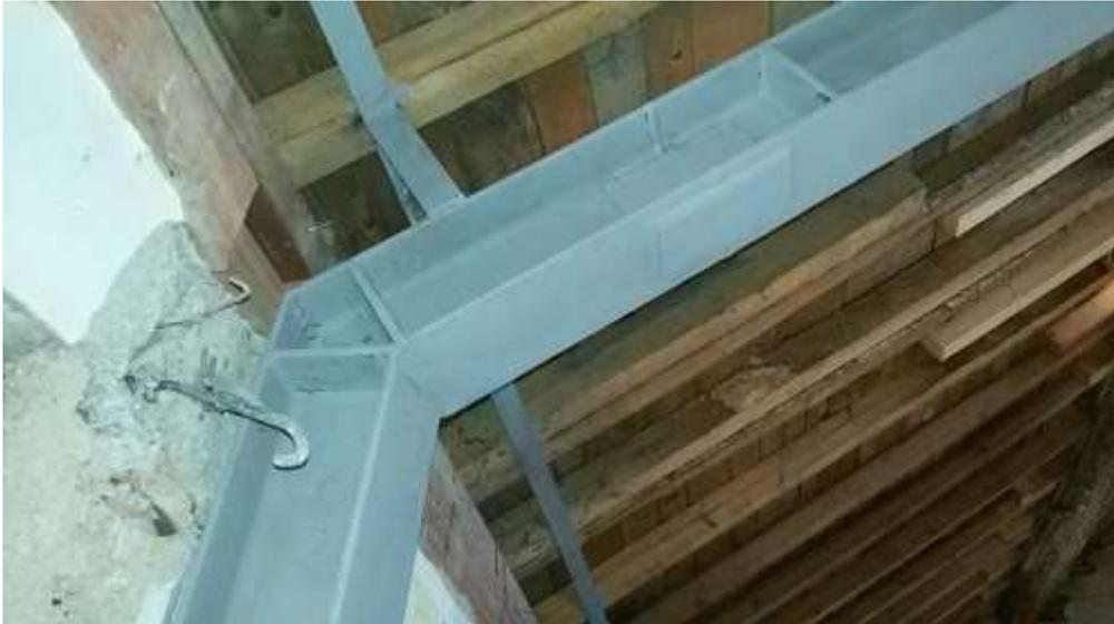
Figura 9 Giunzione testa a testa con doppiature di rinforzo: soluzione sconsigliata perché il giunto testa a testa non è più ispezionabile dopo la sovrapposizione delle piastre.
