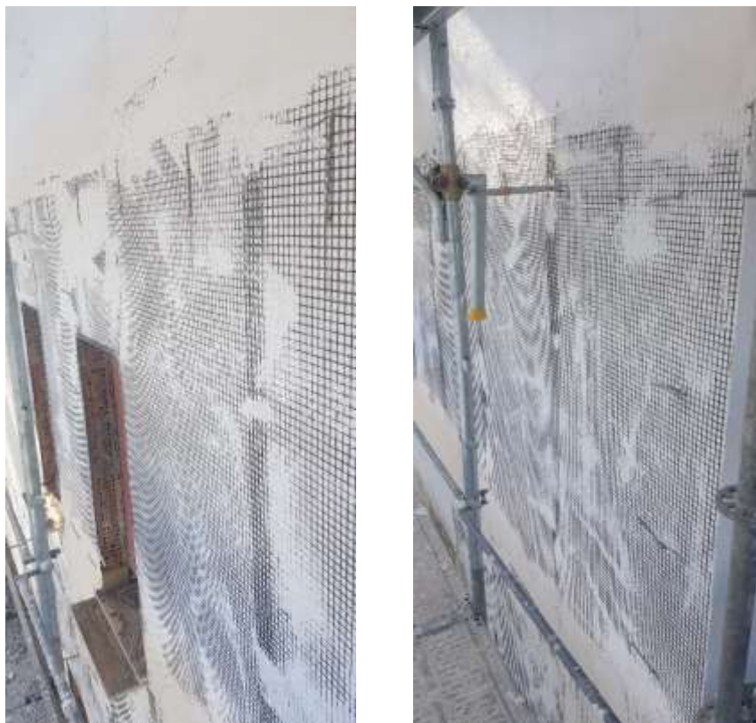
Figura 2 - L'intervento di antiribaltamento delle facciate esterne
