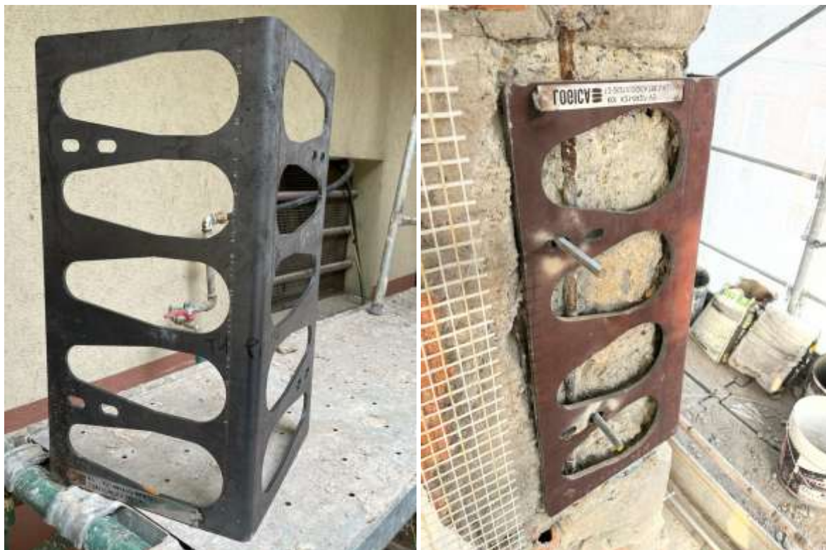
Figura 5 - Esempi di piastre di irrigidimento del nodo
