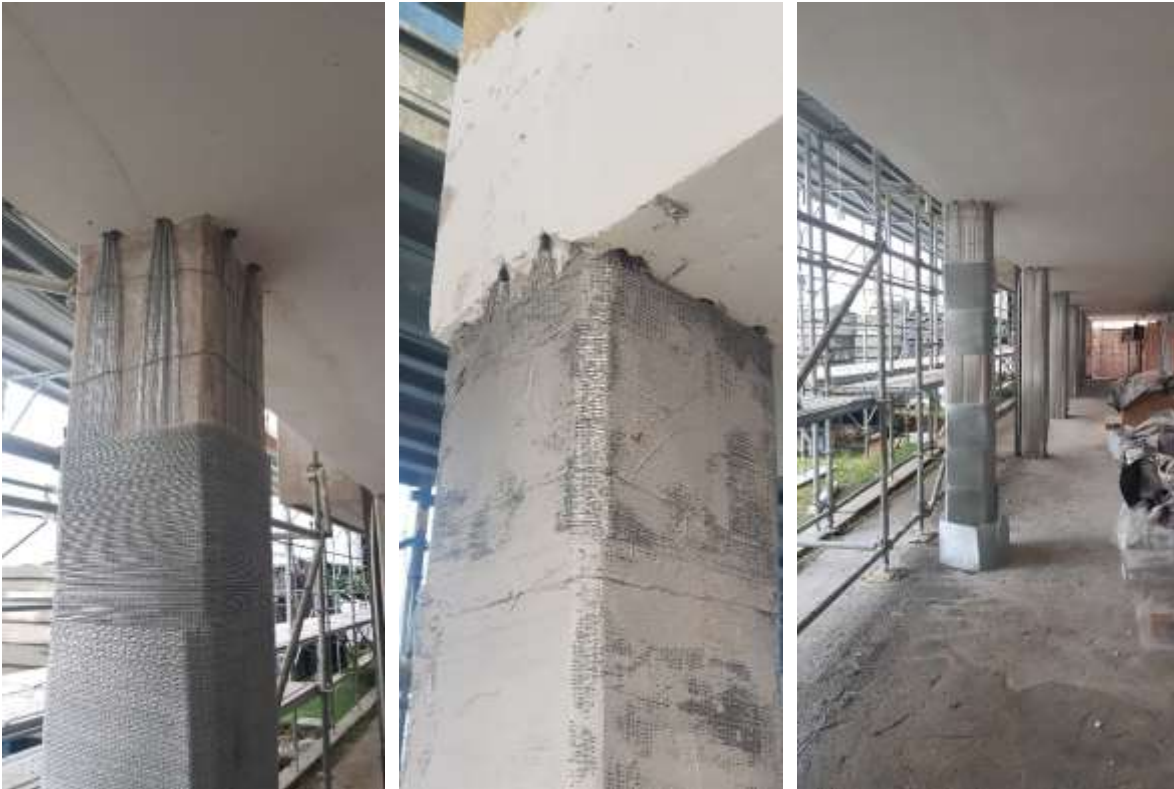
Figura 3 - L'intervento sui pilastri a pilotis del piano terra
