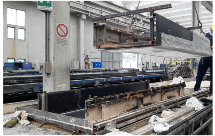
Figure 14. Three-dimensional slab casting. / Getto della lastra tridimensionale.
