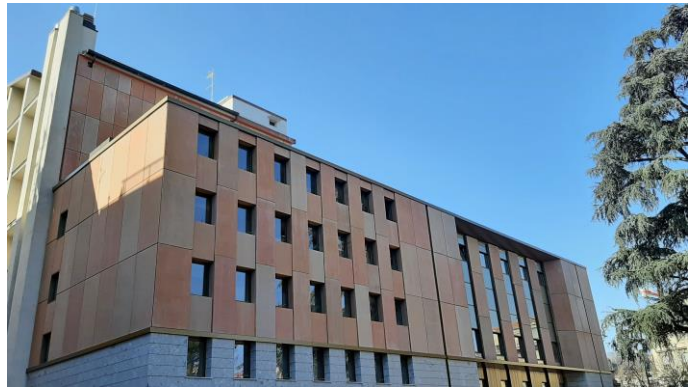
Figure 3. View of the Eastern façade. / Vista della facciata est.
