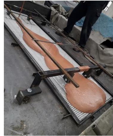
Figure 15. Flat slab casting. / Getto della lastra piana.
