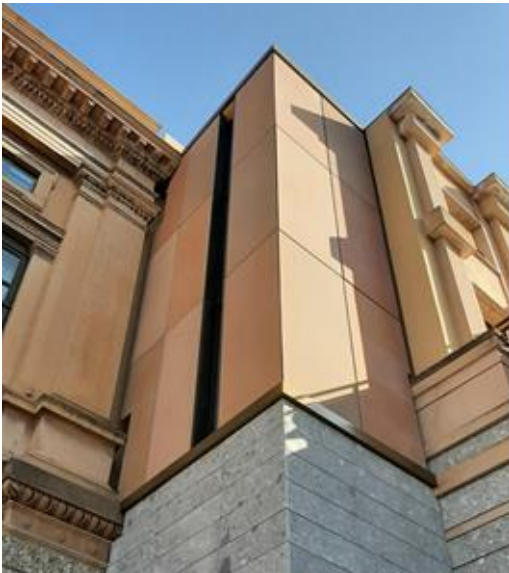
Figure 25. Cladding of the access stairs to the gallery. / Rivestimento della scala di accesso alle gallerie.
