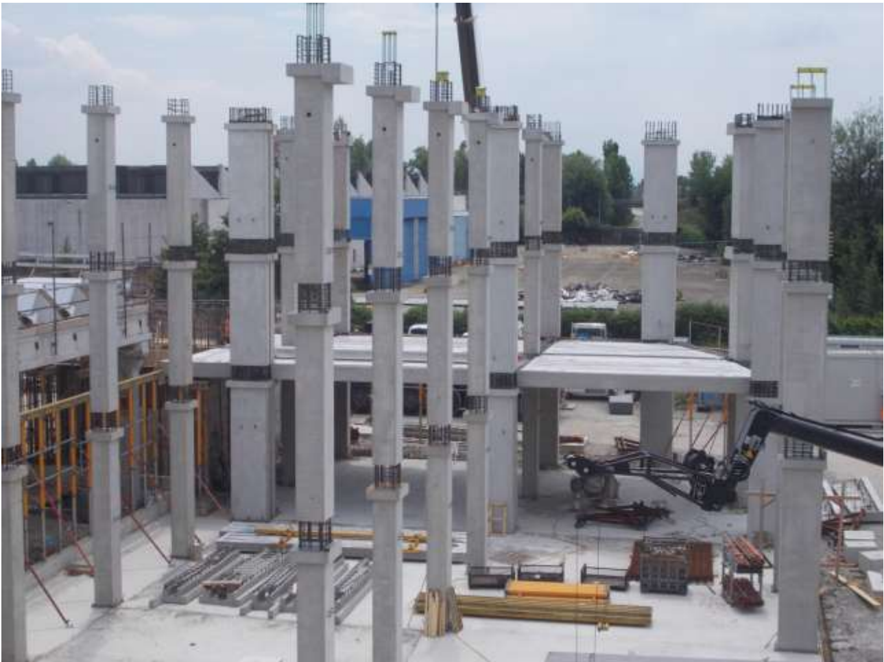
Figura 1 – Fase di montaggio del sistema pluripiano iperstatico (Ampliamento E Pharma, Trento, ing. Mauro Ferrari)
