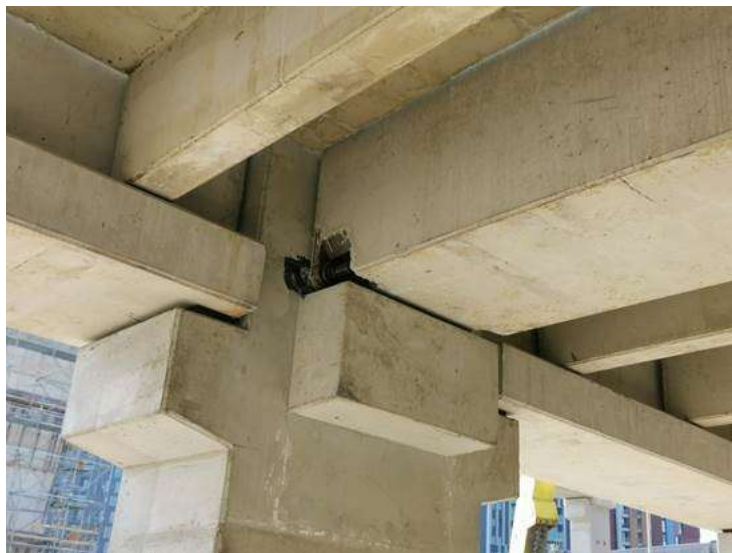
Figura 6 – Vista inferiore dell’unione trave-colonna. (Realizzazione Magnetti Building)
