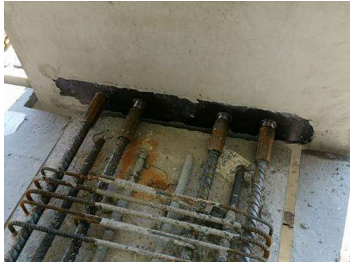
Figura 5 – Vista superiore dell’unione trave-colonna. (Realizzazione Magnetti Building)
