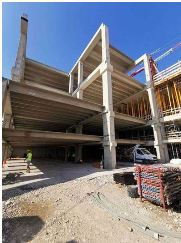
Figura 4 – Fase di montaggio di una struttura prefabbricata con unione rigida trave-colonna. (Realizzazione Magnetti Building)
