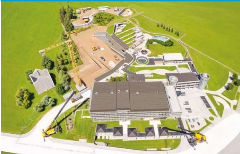
Figura 1. Vista generale dell'area di cantiere
