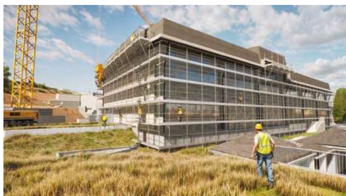
Figura 2. Realizzazione ponteggio di facciata coerentemente allo sviluppo non lineare della facciata e della copertura
