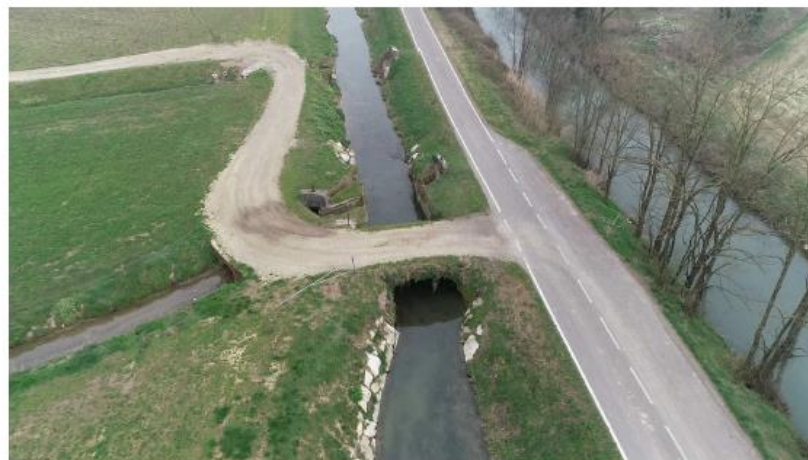
FIGURA 7-2 RIPRESA AEREA TRAMITE DRONE DEL CANALE QUISTRA NEL TRATTO A VALLE DELLA SP26
