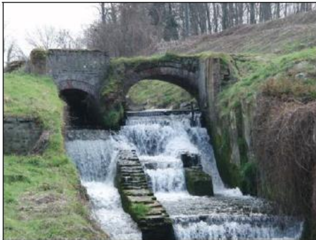
FIGURA 3-5 PONTICELLO DI ATTRAVERSAMENTO CARRAIO SULLA STRADA VICINALE DELLA PIEVE DI GRUMONE
