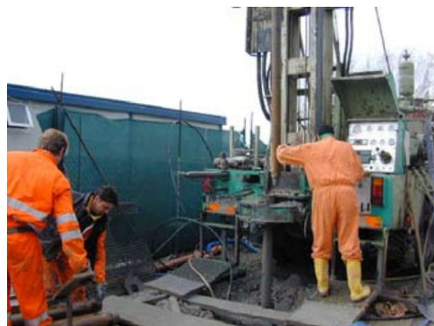
Figura 6 – Esecuzione della perforazione per l'installazione di sonde geotermiche verticali.
