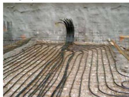
Figura 10 - Sonde orizzontali disposte sottofondazione [3].
