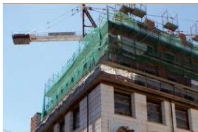
Ampliamento e sopra elevazione
