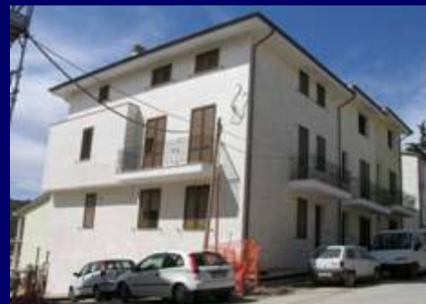
Nuova palazzina privata, San Giuliano di Puglia (13 HDRB + 2 SD, 2007)
