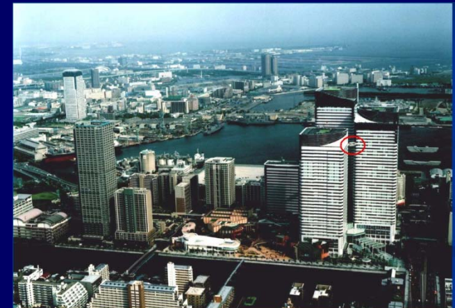
“Active dissipation bridge” (ADB) fra edifici di notevole altezza
