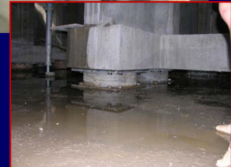
↑ Russian International Olympic University (8 edifici in c.a.) in costruzione su on 996 LRB cinesi
