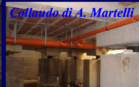
Palazzina a Fabriano, danneggiata dal sisma del 1997 (56 HDRB, 2006)
