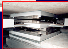
Retrofit con sottofondazione del National Western Art Museum (Le Corbusier) e dei Gates of Hell, Tokyo (1999)
