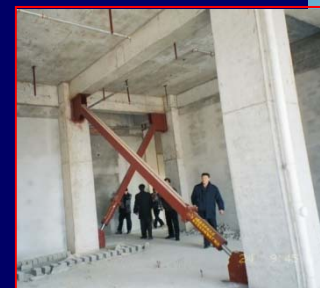
Edificio alto cinese protetto da VD
