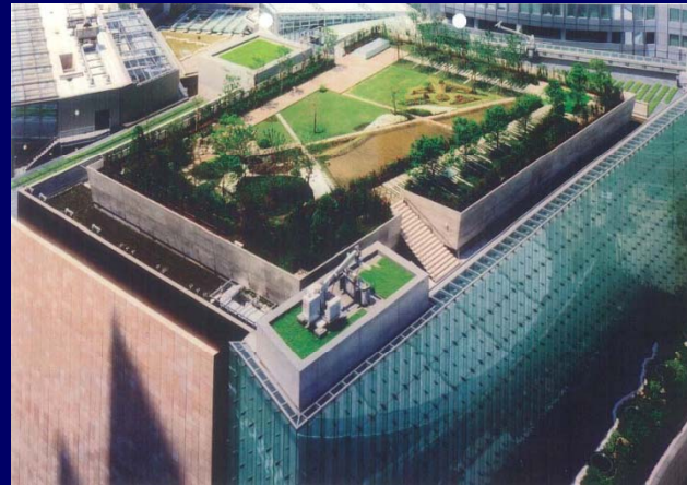
Giardino pensile (“Green Mass Damper” o GMD) utilizzato come “Tuned-Mass Damper” (TMD)
