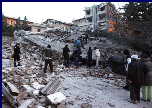
05/04/2009: numerosi edifici crollano o sono fortemente lesionati durante il terremoto dell'Abruzzo
