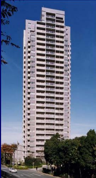
Edificio di 87,4 m, Tokyo (2000): 30 LDRB + 99 EPD, T = 4 s; trazione
