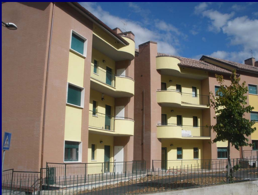
Adeguamento sismico con l'isolamento dell'edificio residenziale di Via dei Tigli, località Pianola (L'Aquila) (42 HDRB e 62 SD, progetto dei soci GLIS G. Mancinelli e D. Corsetti, collaudo statico in c.o. di A. Martelli in maggio 2014)
