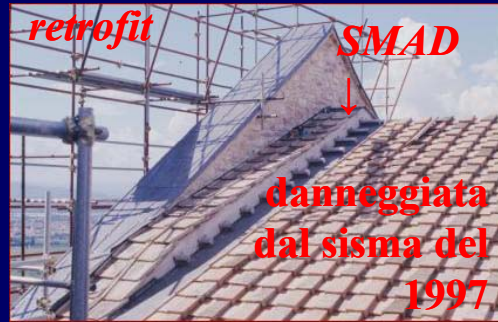
Basilica Superiore di San Francesco in Assisi (2 · 47 SMAD + 34 STU, 1999)
