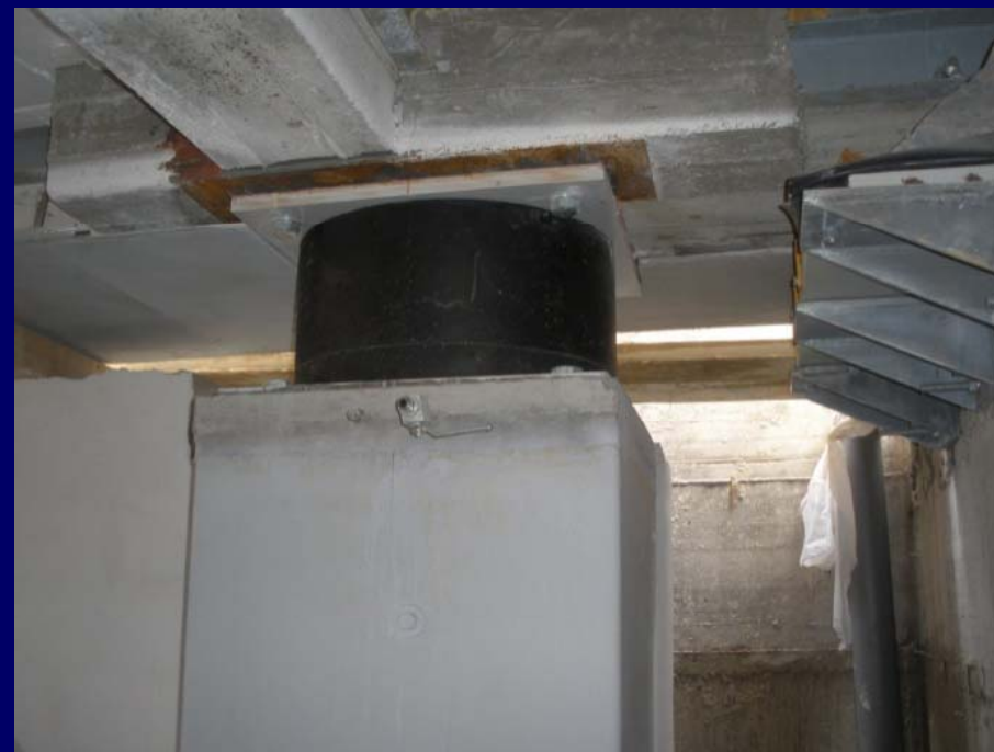
Adeguamento sismico con l'isolamento dell'edificio residenziale di Via dei Tigli, località Pianola (L'Aquila) (42 HDRB e 62 SD, progetto dei soci GLIS G. Mancinelli e D. Corsetti, collaudo statico in c.o. di A. Martelli in maggio 2014)
