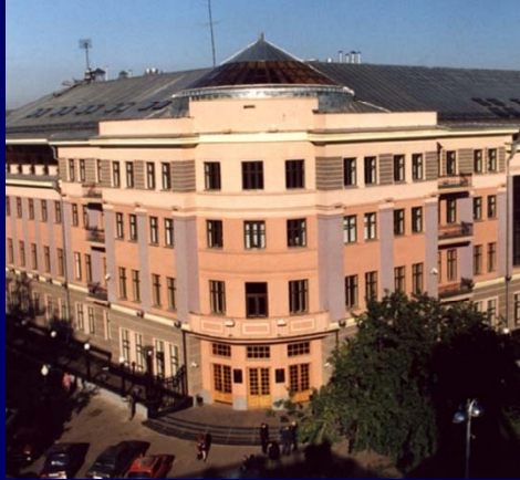
Banca centrale di Irkutsk (HDRB cinesi)
