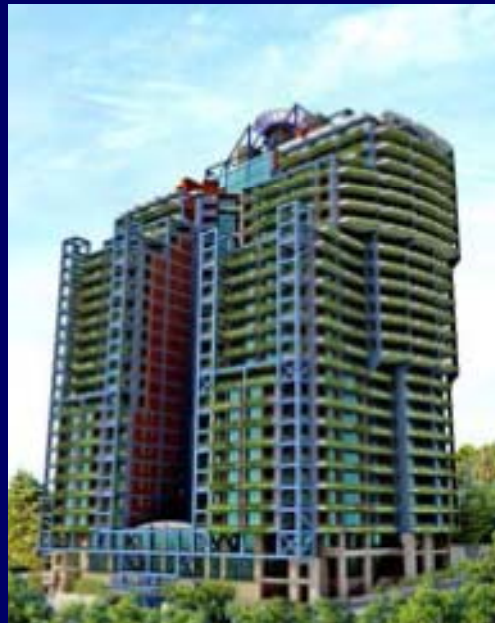
← Uno dei 4 edifici di 28-33 piani in c.a. del complesso Zarya , in costruzione su 160 LRB cinesi
