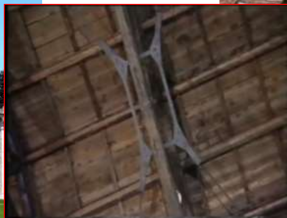
Santa Maria di Collemaggio in L'Aquila: EP steel braces on the roof
