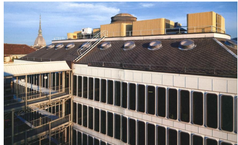
Foto del 1973 – ultimazione dei lavori – dettaglio impianti
