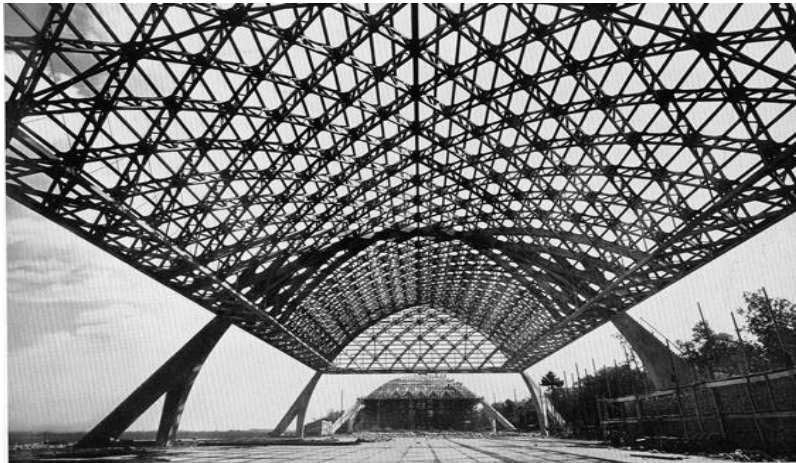
Hangar, Orvieto, Pier Luigi Nervi, 1935-1942
