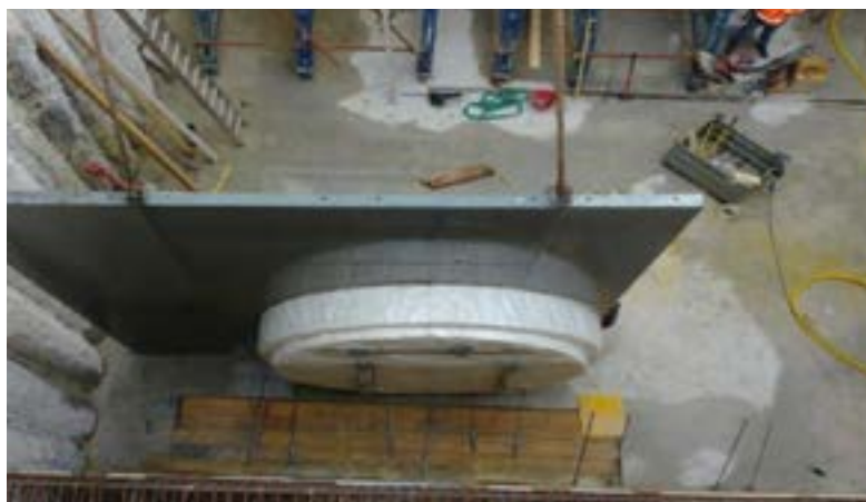
SCAVO DEL POZZO PER MT
