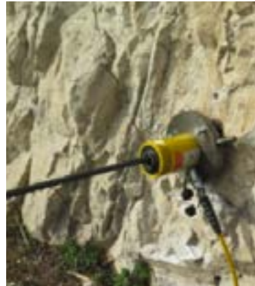
Prove di snervamento e rottura delle barre
