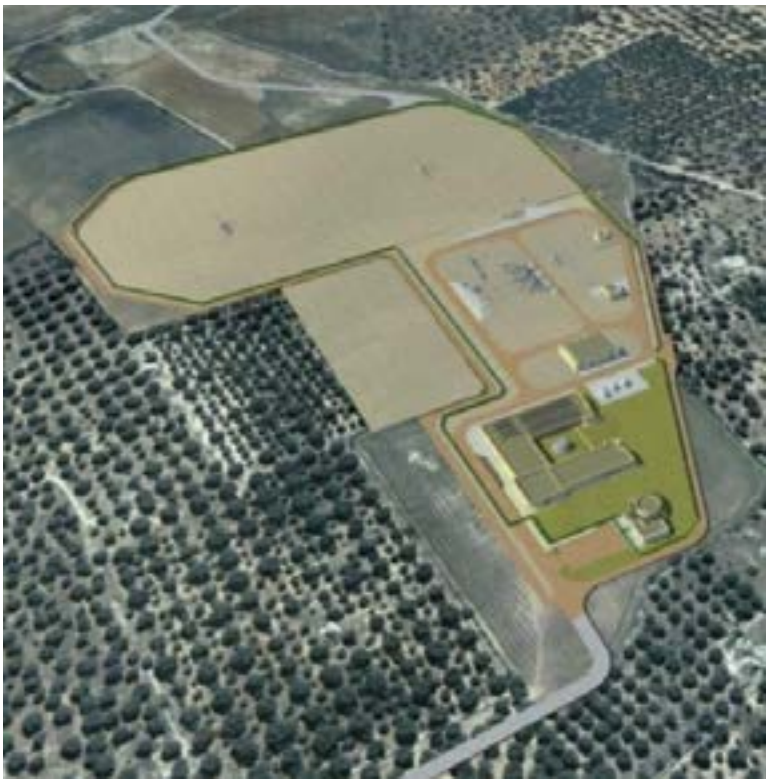
TERMINALE DI RICEZIONE - PRT Il PRT serve per misurare, controllare e quindi immettere gas naturale nella rete di Snam. Non si tratta di una centrale che produce emissioni nocive, ma è solo un luogo di passaggio del gas. Il Terminale di Ricezione funge da centro di controllo e monitoraggio dell'intero gasdotto, attivo 24 ore su 24, costituendo un ulteriore elemento di sicurezza per le popolazioni locali
