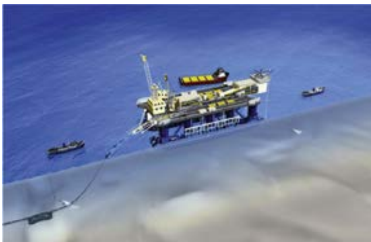
LA POSA DELLA CONDOTTA OFFSHORE. Il gasdotto verrà installato in mare utilizzato la tecnica di posa ad "S"
