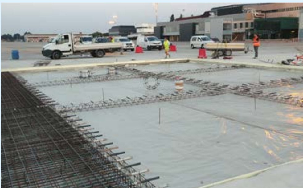
Foto 3: zona getto con disposizione di armatura
