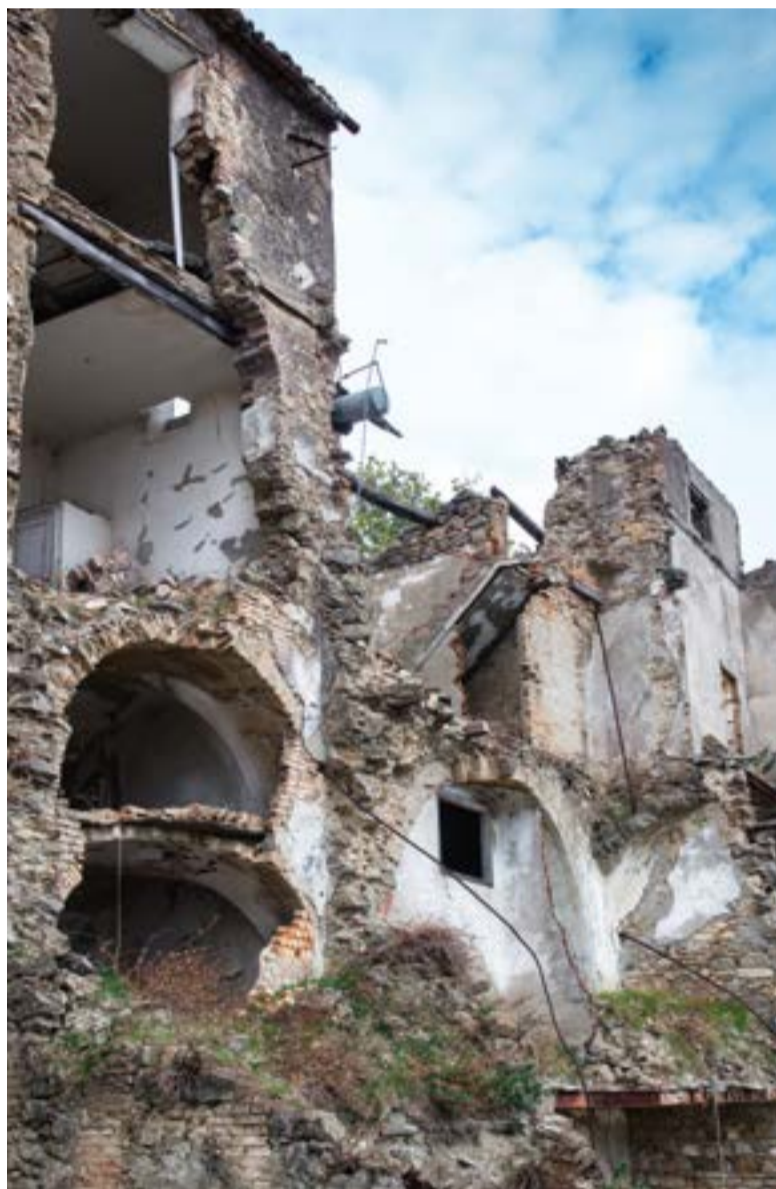
Danni del terremoto dell'Irpinia
