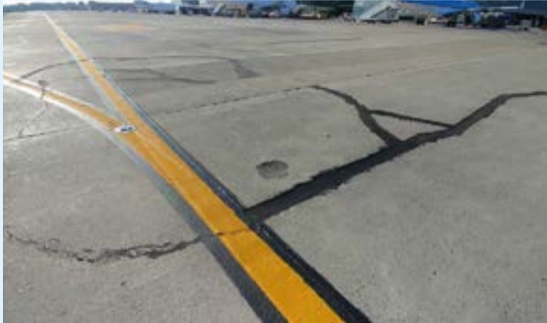
Foto 1: area di intervento
