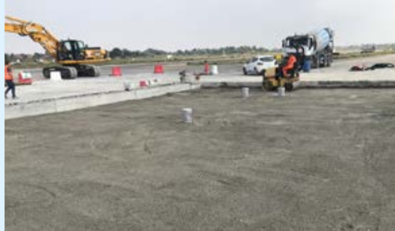
Foto 2: stesa e compattazione del materiale di fondazione
