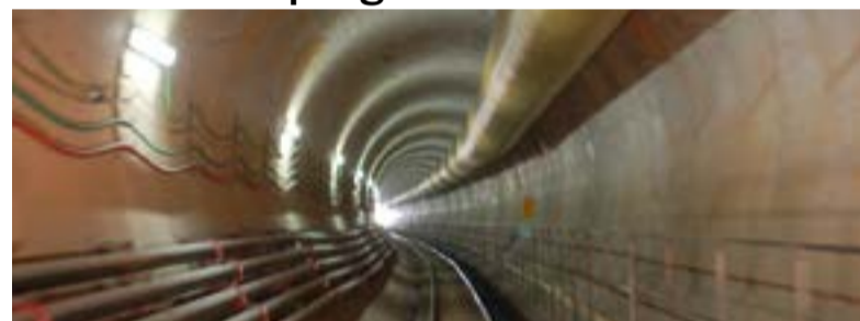
Foto 3. Galleria TBM (© Metro C scpa)
