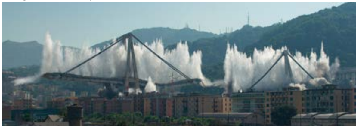
Genova, 28 giugno 2019, ore 9.37: l'esplosione delle pile 10 e 11
