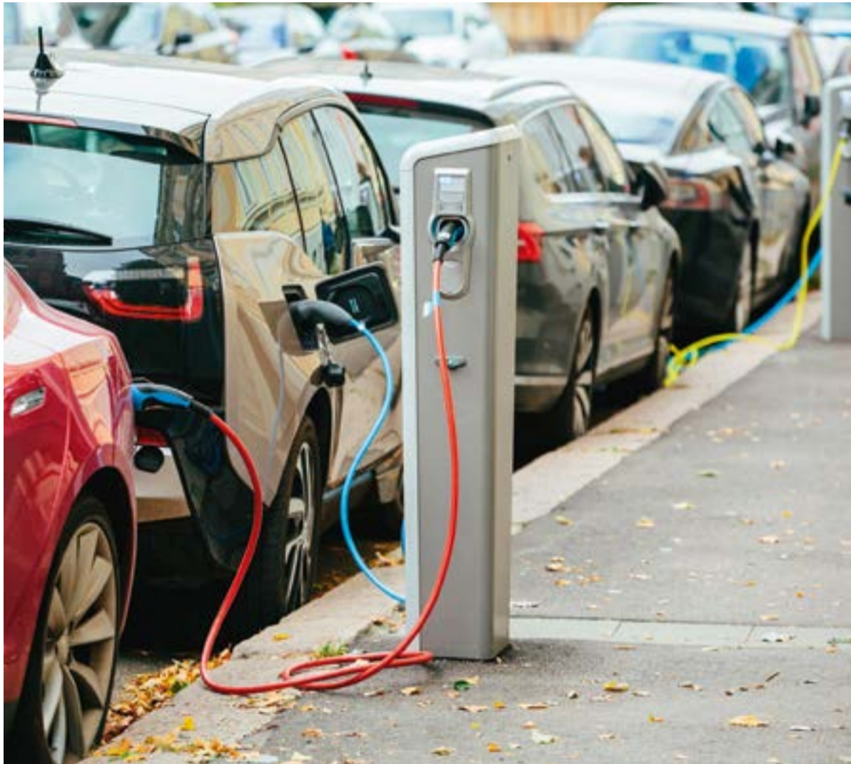
STAZIONE DI RICARICA PER VEICOLI ELETTRICI
