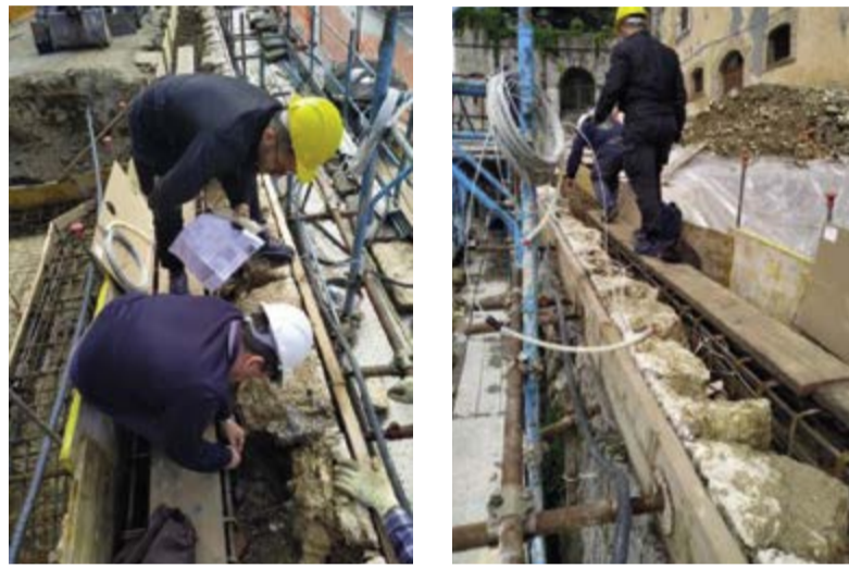
Figura 8. Ingegneri all'installazione dei sensori a fibre ottiche
