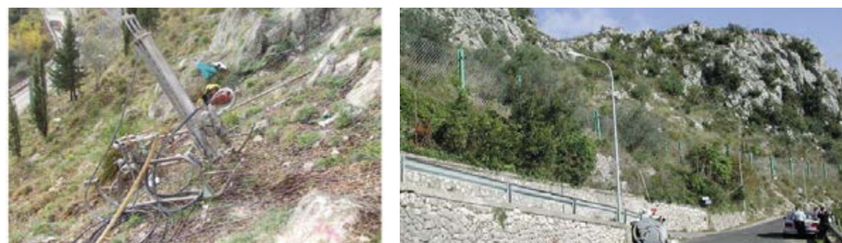
Figura 6. Fronte di roccia e muraglione di contenimento monitorati con sensori a fibre ottiche. Un progetto dell'ing. Diego Dell'Erba con la collaborazione della Sismlab, spin-off dell'Università della Calabria
