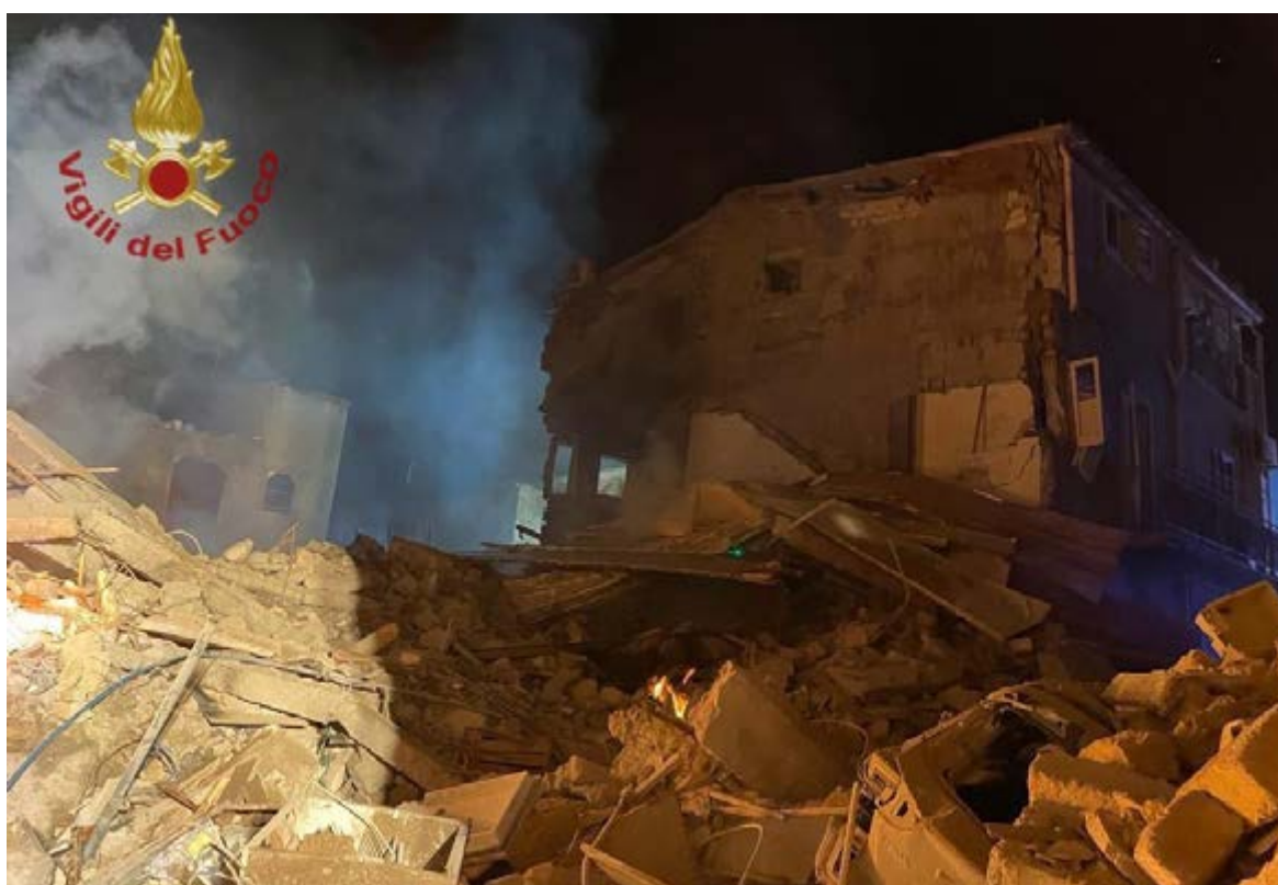
Le macerie immediatamente dopo l'esplosione a Ravanusa. Fonte: Vigili del Fuoco
