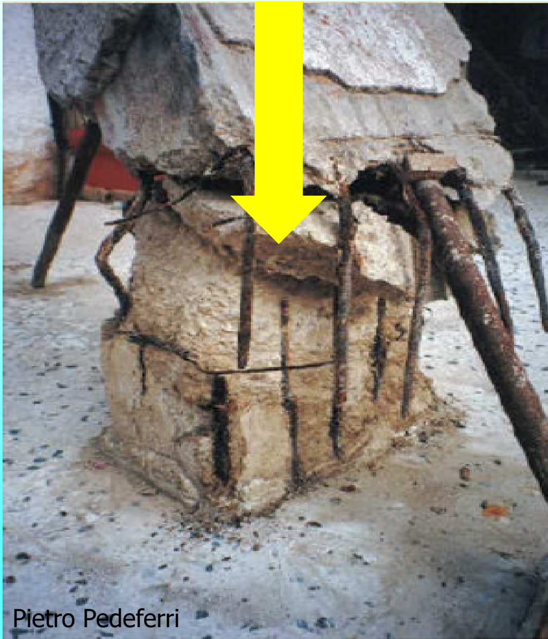
Fig. 1.6 Corrosione delle armature di un pilastro di un edificio di 7 piani crollato a Palermo nel 1999
