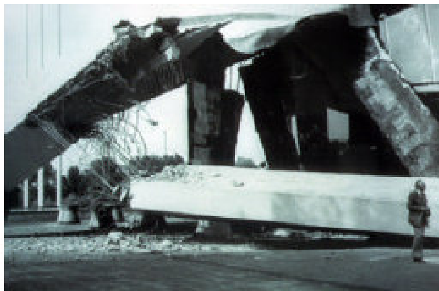
Fig. 1.19 Crollo della Congress Hall di Berlino per cedimento da corrosione sotto sforzo di armature precomprese (1981)
