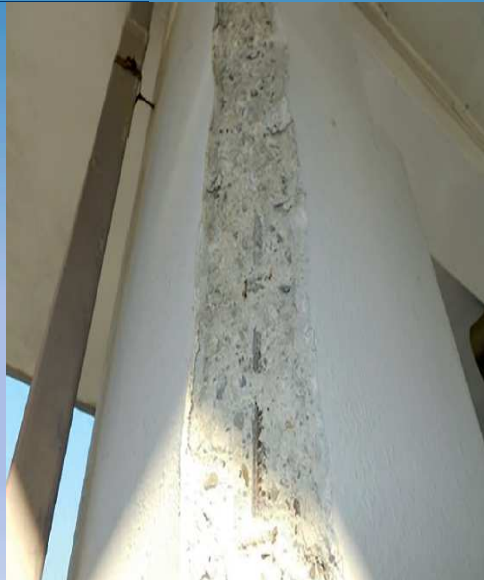
Messa a nudo della armature
