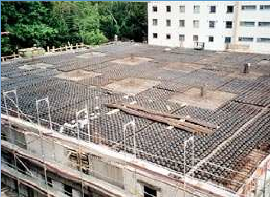
ESECUZIONE DI SOLAIO BIDIREZIONALE
